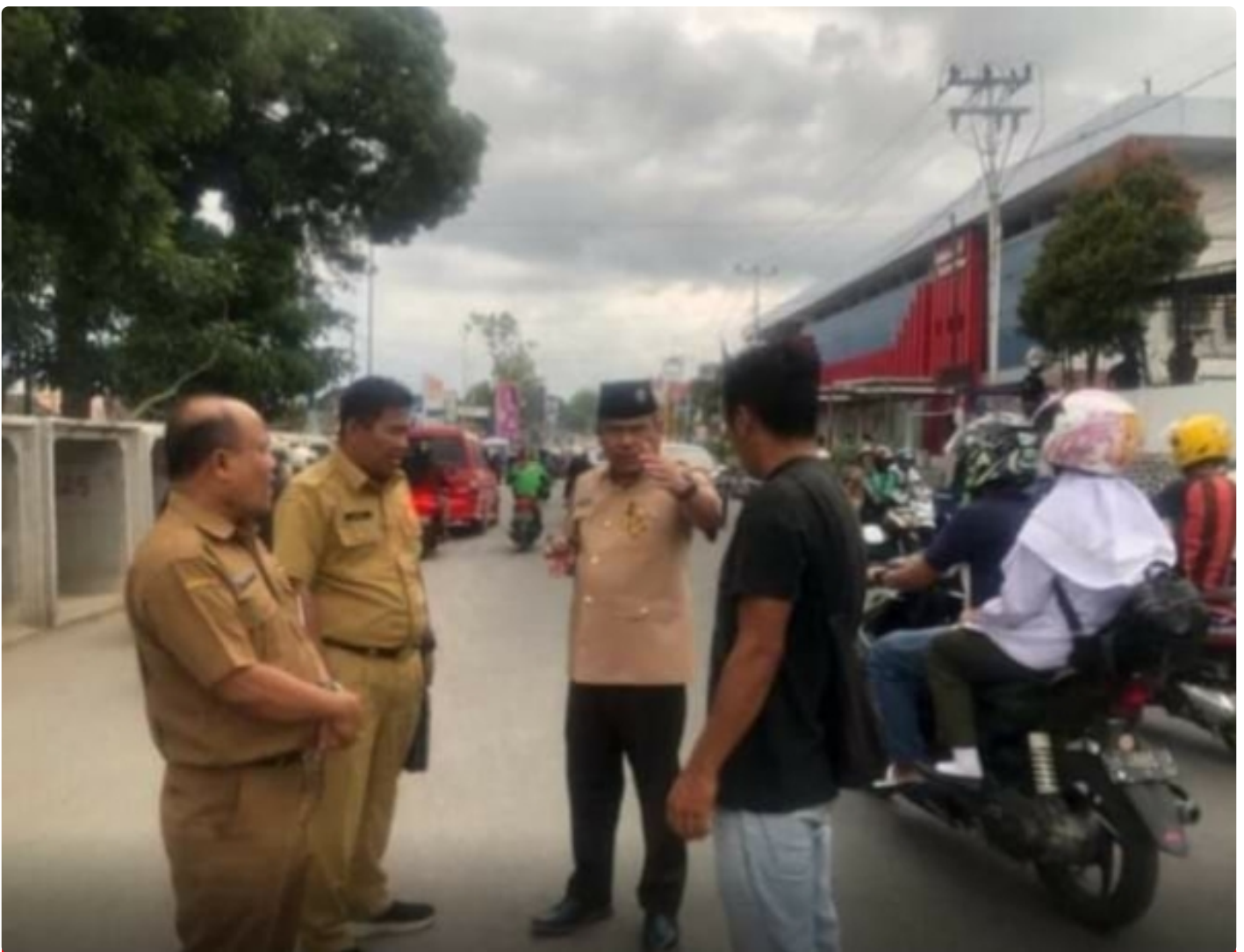
Sekda kota Bukittinggi Martias Wanto bersama jajaran mengecek pekerjaan drainase yang masih berjalan
