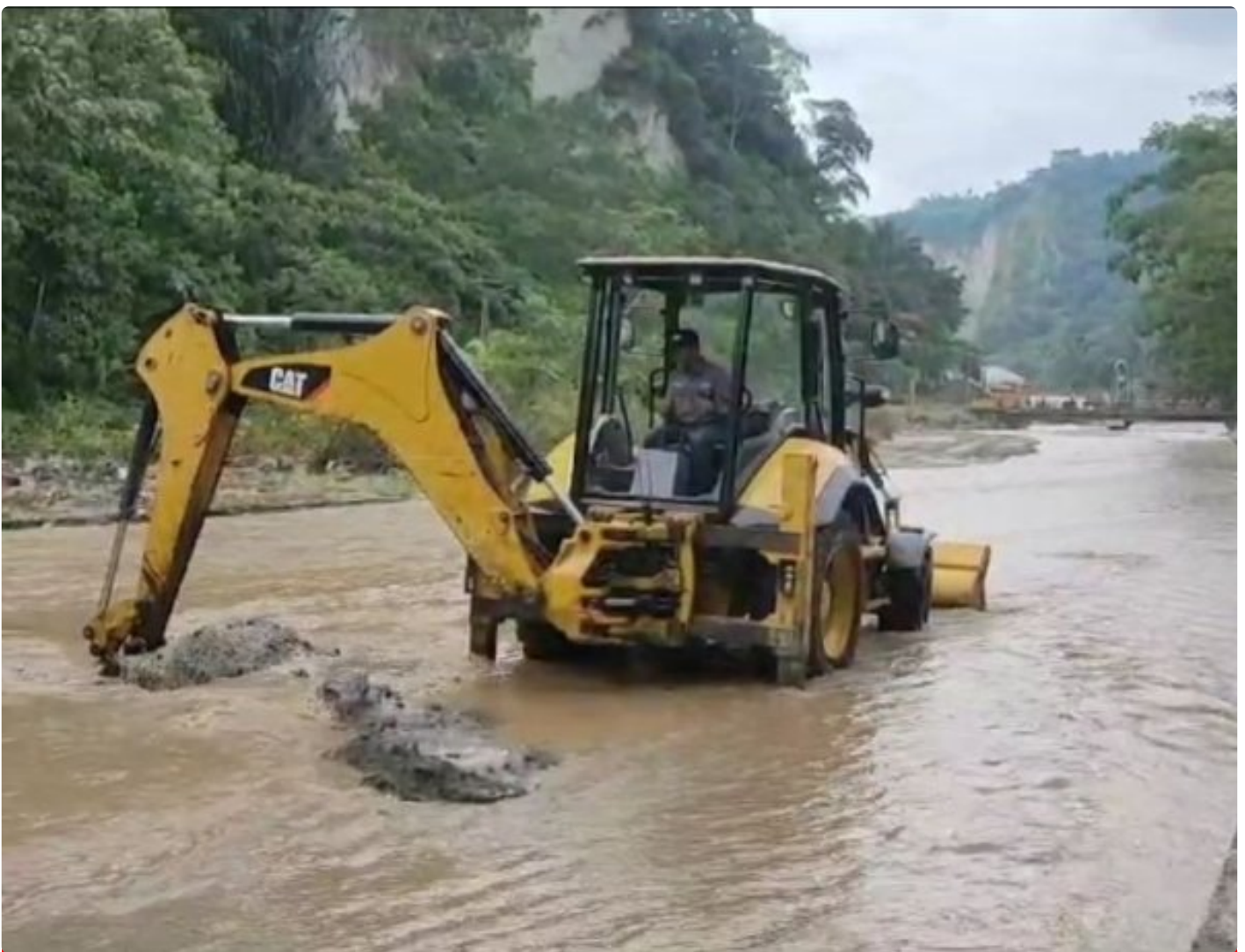
Pemko Bukittinggi Normalisasi Sungai Batang Sianok Pasca Banjir
